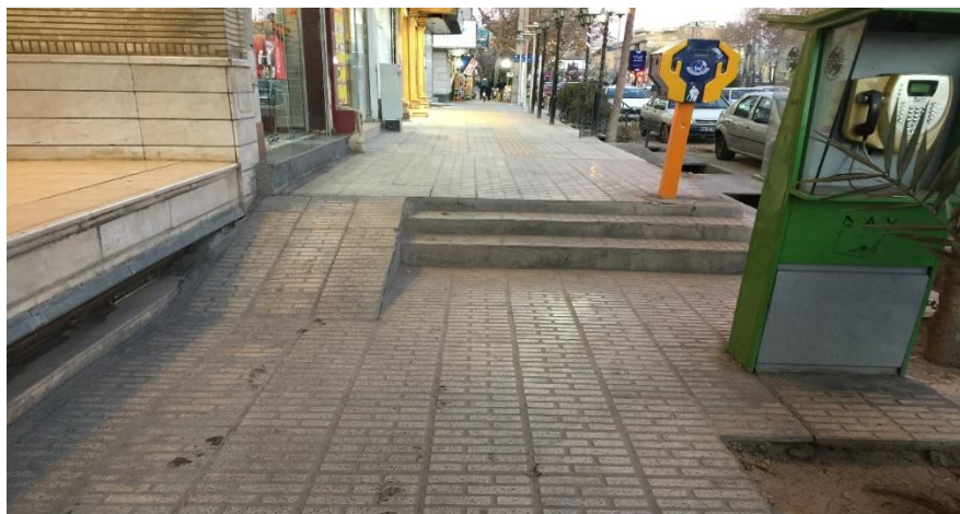
شکل ۷- اجرای پله و رمپ جهت تسهیل در عبور عابرین و افراد دارای صندلی چرخدار
