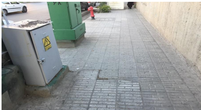
شکل ۳- قرارگرفتن جعبه های تاسیسات تلفن و برق و شیر آتشنشانی در مسیر پیاده رو
