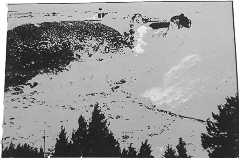
شکل ۱. تخریب سد تتون ۲ در آیداهو ۳ ایالات متحده آمریکا بر اثر گسترش نشست.
