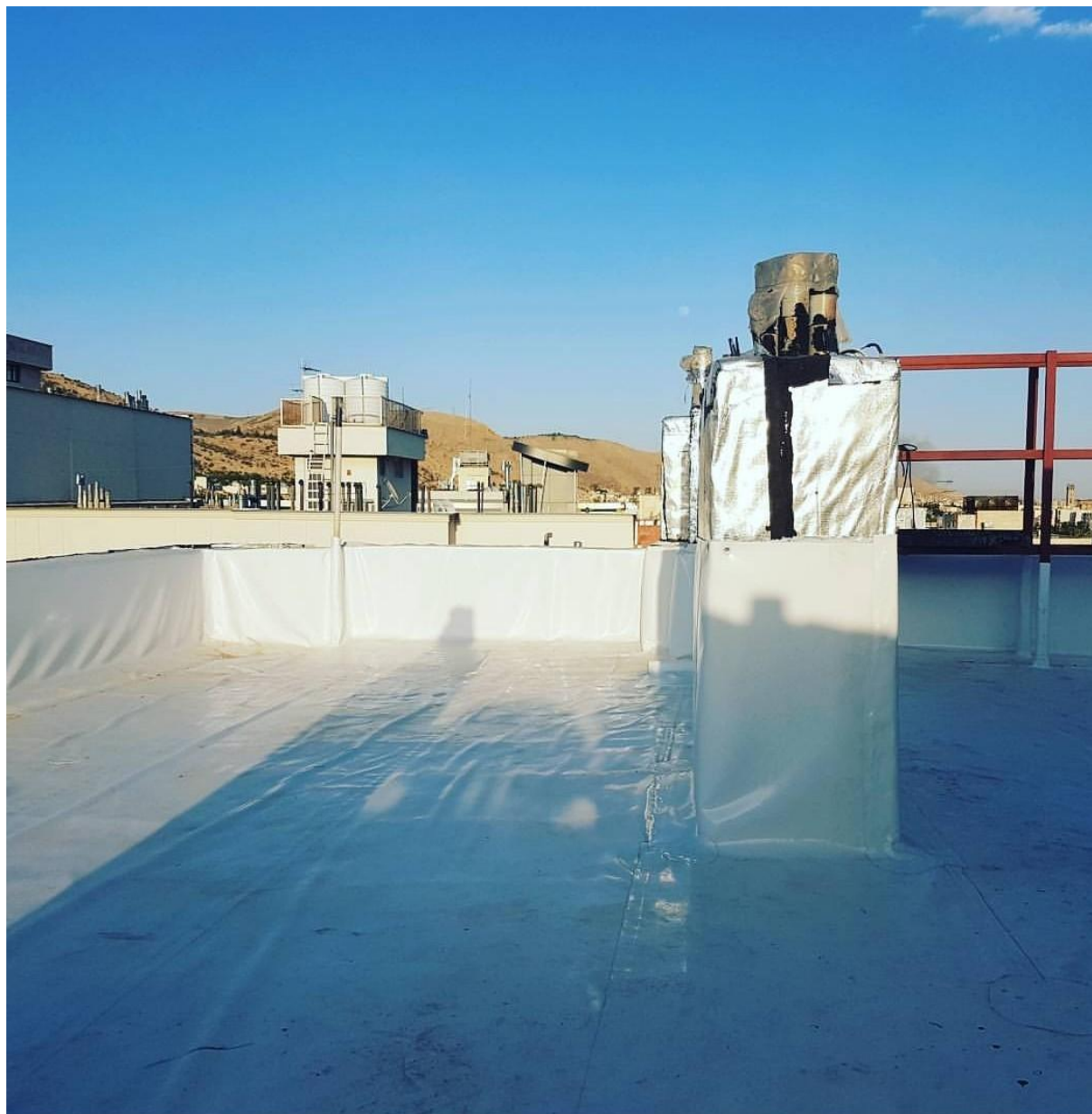
شکل ۲- بام سبز در حال اجرا در محله ابریشمی خیابان یزدانمهر شهر شیراز
